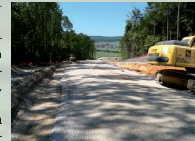
Neubau einer Bundesstraße
