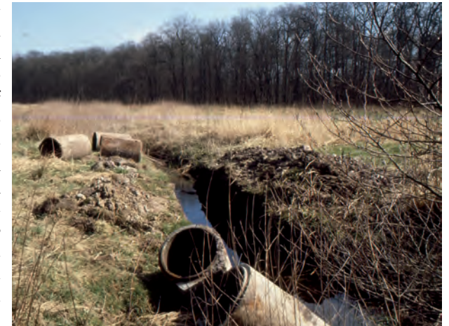
Rückbau von Verrohrung zur Optimierung von Larvengewässern
